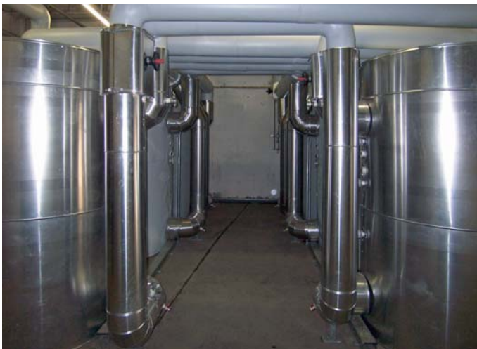
Pufferspeicher in der Heizzentrale mit 6 x 2.000 l Fassungsvermögen
