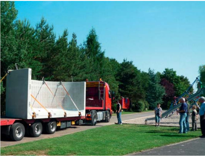
Lieferung der zwölf Stahlbeton-Fertigteile für die beiden unterirdischen Hackschnitzelbehälter
