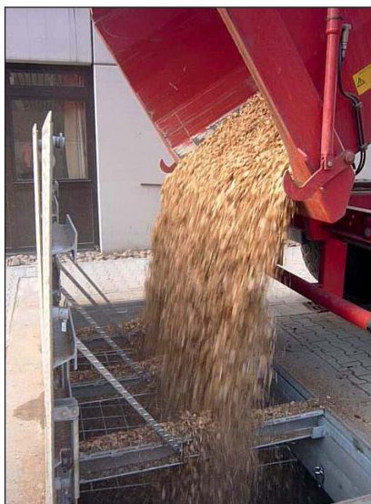
Befüllen eines unterirdischen Hackschnitzelbehälters
