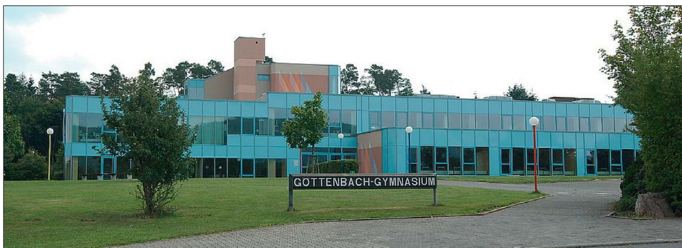
Göttenbach-Gymnasium in Idar-Oberstein, ein Teil des Schulzentrums „Auf der Bein“, das mit einem Nahwärmenetz versorgt wird
