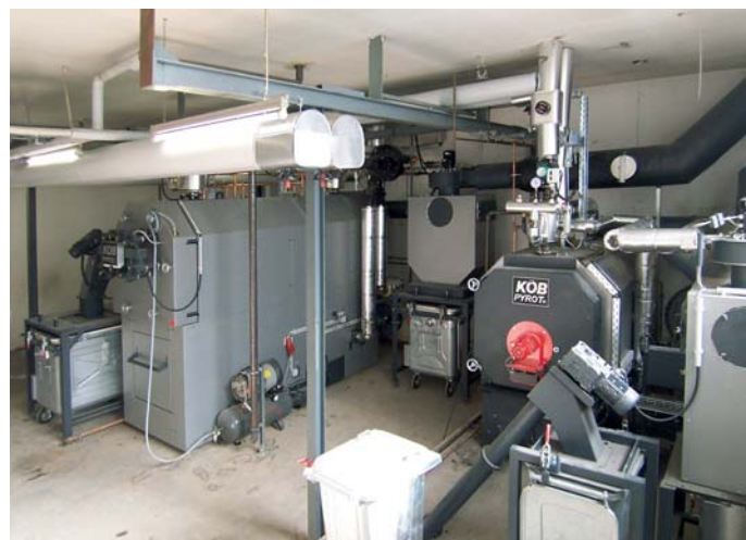
Heizzentrale mit den beiden Hackschnitzelkesseln unmittelbar neben den außen befindlichen Hackschnitzelbehältern
